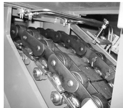
Rolltreppen-Ketten-Schmierung
